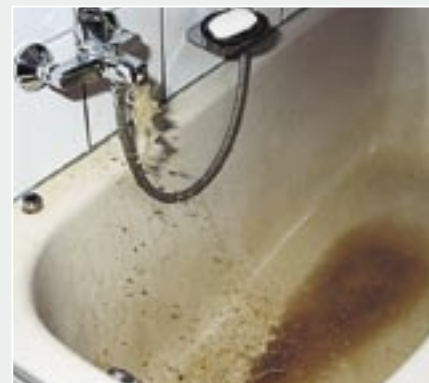
Insbesondere bei Warmwasserleitungen zieht sich die Prozedur der pneumatischen Reinigung gerne über mehrere Stunden hin.
